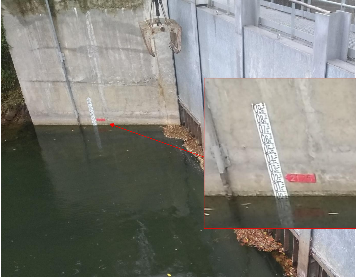
Figure 4 : Echelle limnimétrique à l'entrée du canal d'amenée
